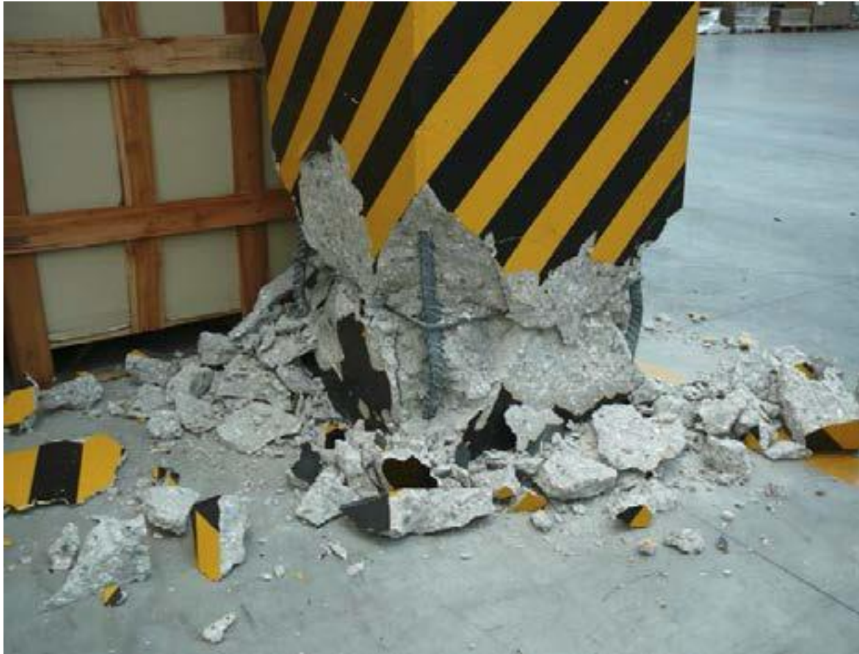
Danneggiamenti alla base di un pilastro (insufficiente staffatura)
